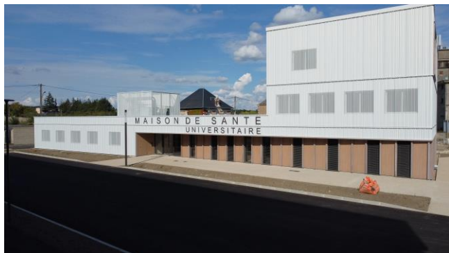
Construction de la Maison de Santé Pluridisciplinaire Universitaire
